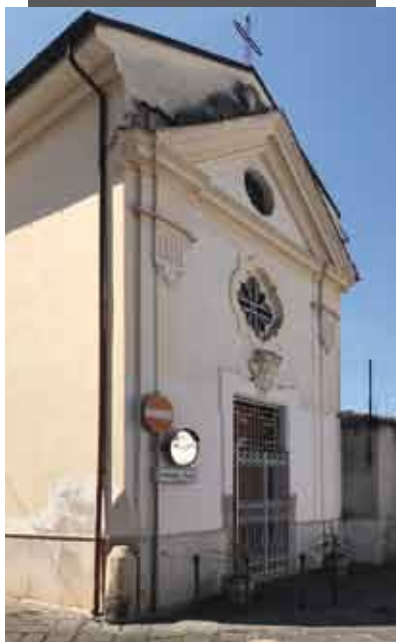
Casino Corsini, la cappella
