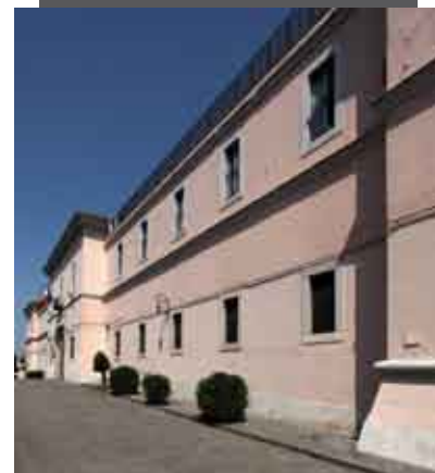
A lato e sopra, carcere borbonico, veduta della corte con la cappella e del prospetto principale
